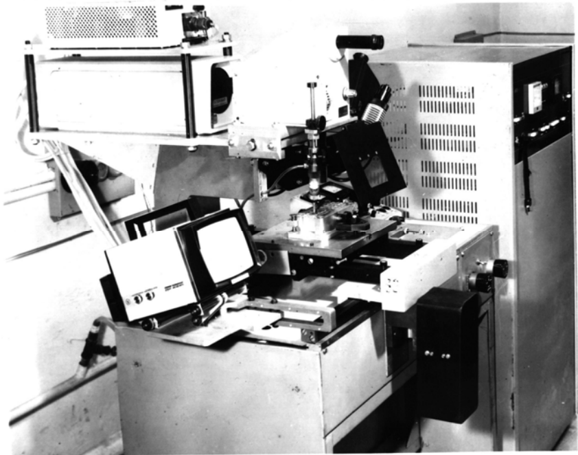
Рис. 5. 2. Экспериментальная установка лазерной пайки УЛП-1
